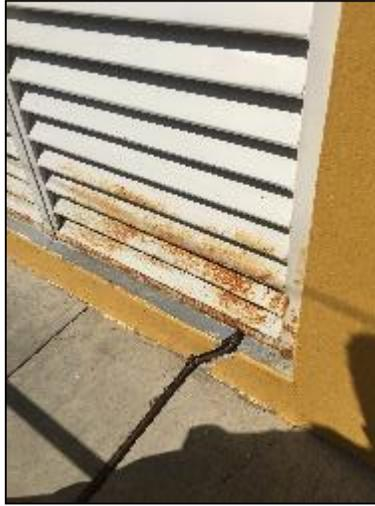
**Foto 84.** La toma general de agua potable del hospital se encuentra expuesta, puede presentar fugas y ocasionar problemas dentro del hospital.
