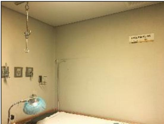
**Foto 27.** En el área de recuperación se encuentran orificios entre plafón y muros que forma bacterias dañinas para el paciente.
