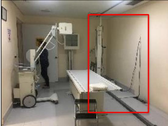
**Foto 31.** El cuarto de rayos "X", el cableado se encuentra expuesto y sin ser propiamente identificado por colores.
