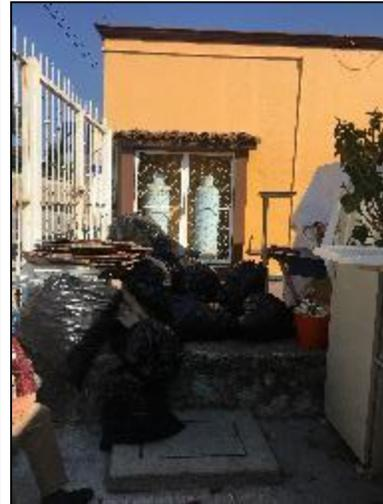
**Foto 73.** Los tubos de gas LP no se encuentran señalizados de acuerdo a la norma de colorimetría del hospital, lo que puede ocasionar una confusión del mismo.
