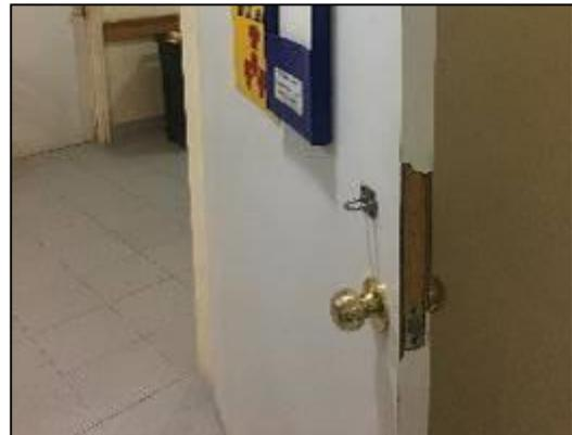
**Foto 36.** La puerta de acceso a rayos "X" se encuentra rota, lo que permite la salida de radiación a otras áreas del hospital.
