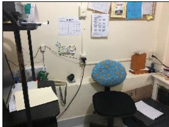
**Foto 46.** Dentro del espacio de estadística no se encuentra el cableado eléctrico con la tubería adecuada de acuerdo a reglamento.
