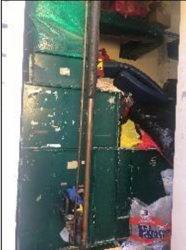
**Foto 65.** El equipo de aire acondicionado se encuentra en condiciones deplorables, generando contaminación de germen en todo el hospital debido al mal funcionamiento del equipo.
