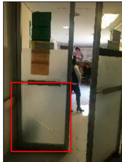
**Foto 4.** La puerta de acceso al área de urgencias se encuentra rota y en malas condiciones de operación, puede causar lesiones si el vidrio se rompe.
