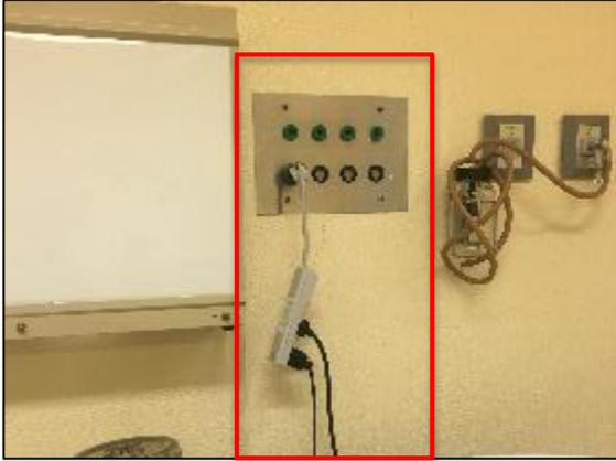
**Foto 21.** Mala conexión de instrumentos en quirófano, generando afectaciones a corrientes eléctricas no reguladas.
