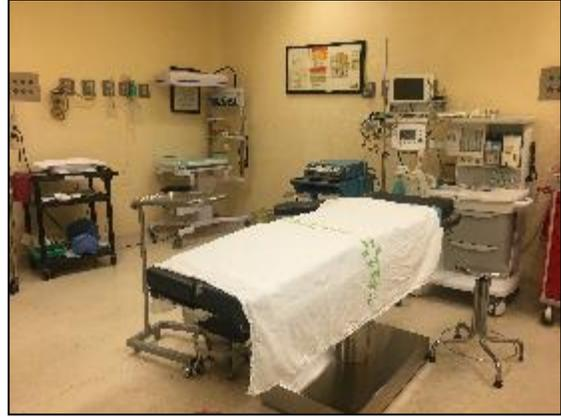
**Foto 22.** Falta de tipografía del color en conexiones eléctricas, gases medicinales, instalaciones hidrosanitarias, genera confusión
