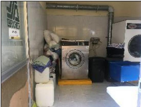
**Foto 81.** El área de lavandería no tiene un adecuado espacio de estantería, los equipos presentan fugas y la pintura se encuentra desgastada.
