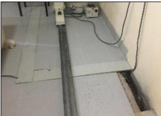
**Foto 35.** Se encuentran cables expuestos, hay orificios que contaminan el lugar acumulando hongos y bacterias.
